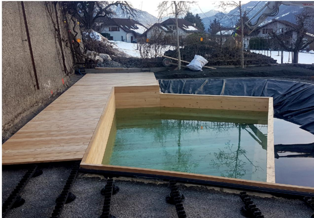
Der Bau eines Schwimmteiches benötigt durchschnittlich ca. 2 Wochen, mit den Umgebungsarbeiten beträgt die Bauzeit ungefähr einen Monat.
